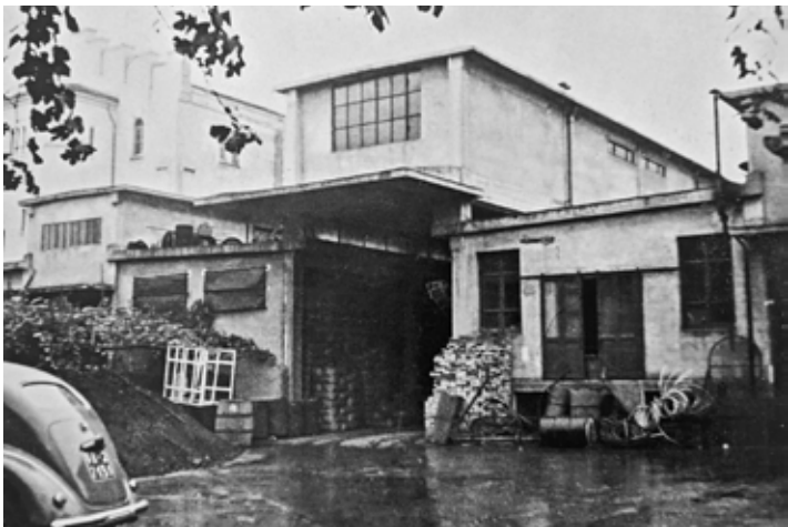
visione generale dello stabilimento (1960 ca.)
