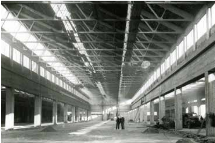
vista generale dell'interno durante il cantiere (1946)
