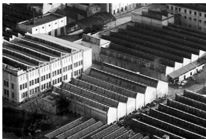
vista generale dell'edificio (1960 ca.)
