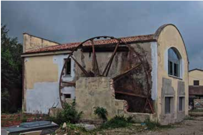
l'edificio prima del restauro (2006)
