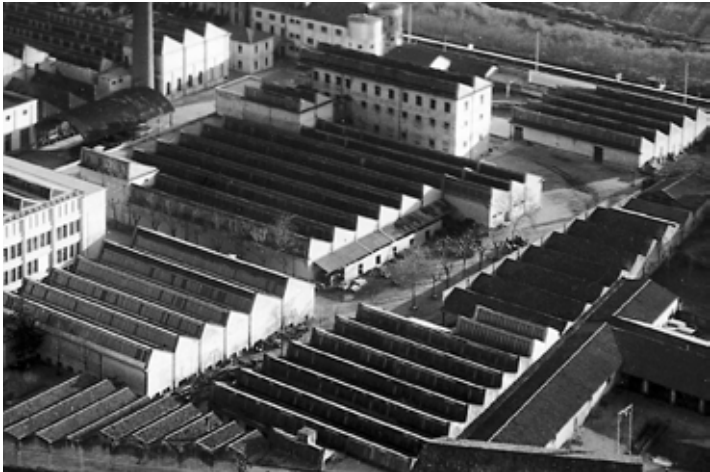
vista generale dell'edificio (1960 ca.)
