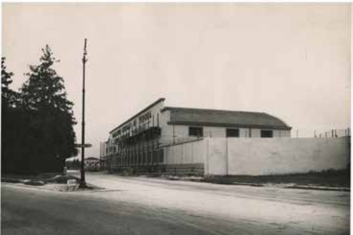
il fabbricato durante le ultime fasi del cantiere (1948)
