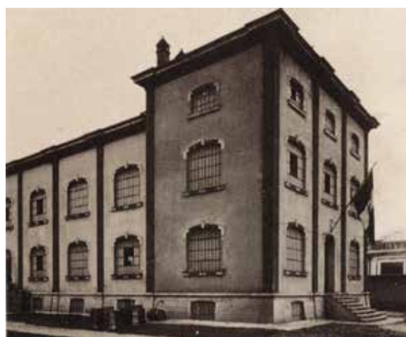
l'edificio nella sua prima impostazione (1932)
