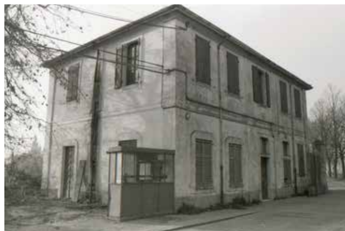
visione della portineria (1986)
