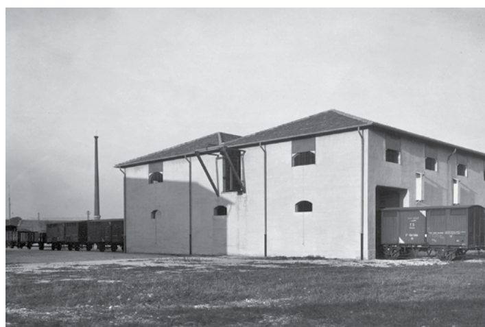
il primo nucleo del fabbricato (1927)
