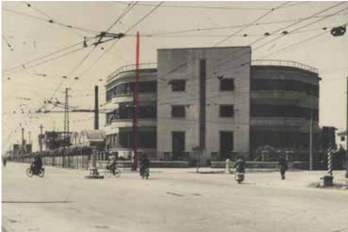
la palazzina uffici (1960 ca.)
