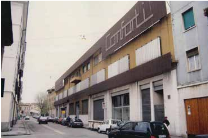
visione generale del complesso (1995)
