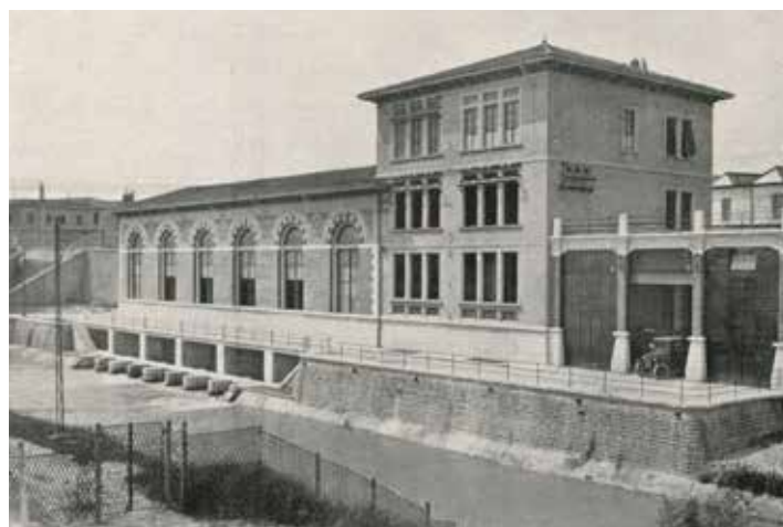
la centrale di Tombetta dopo la realizzazione (1923)
