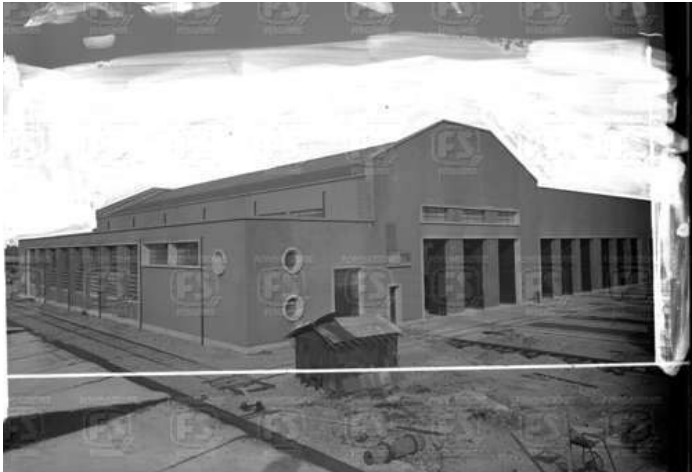
il fabbricato poco dopo la sua costruzione (1938)
