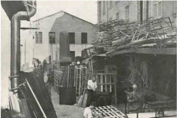
interno dello stabilimento (1930 ca.)
