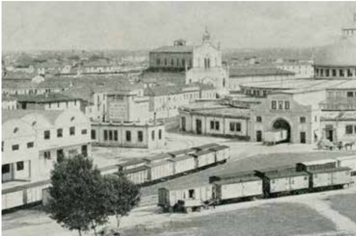
visione generale dei Magazzini Generali (1942)
