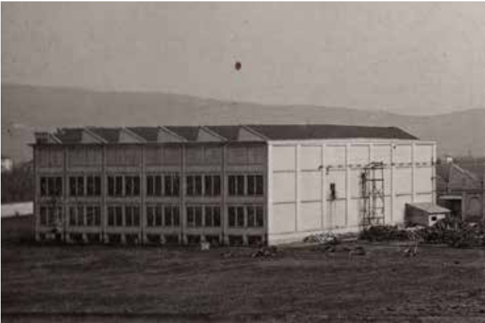
Vista generale dell'edificio (1920 ca.)
