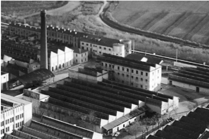
vista generale dell'edificio (1960 ca.)
