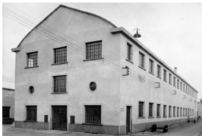
visione generale del fabbricato (1949)
