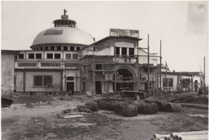
l’edificio durante le ultime fasi del cantiere (1930)
