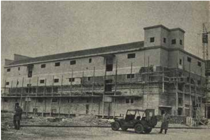
il fabbricato 26 durante il cantiere (1956)
