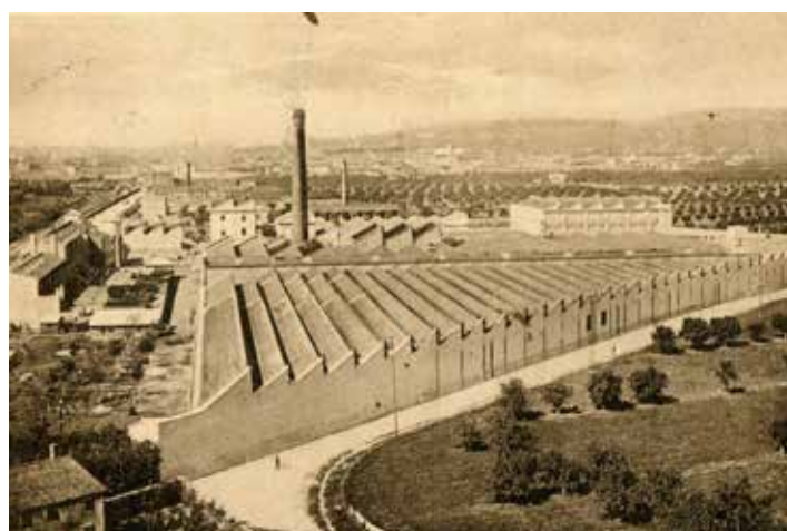
vista generale dell'edificio (1930 ca.)
