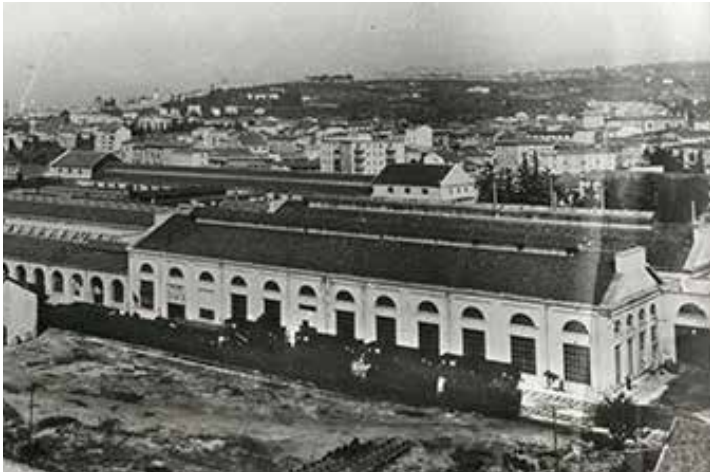
visione generale dei fabbricati (1947)
