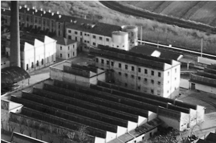
Vista generale dell'edificio (1960 ca.)
