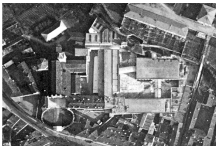
vista aerea dello stabilimento (1926)
