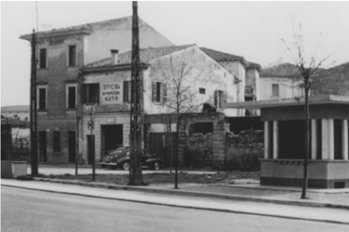
foto generale del fabbricato (1957)
