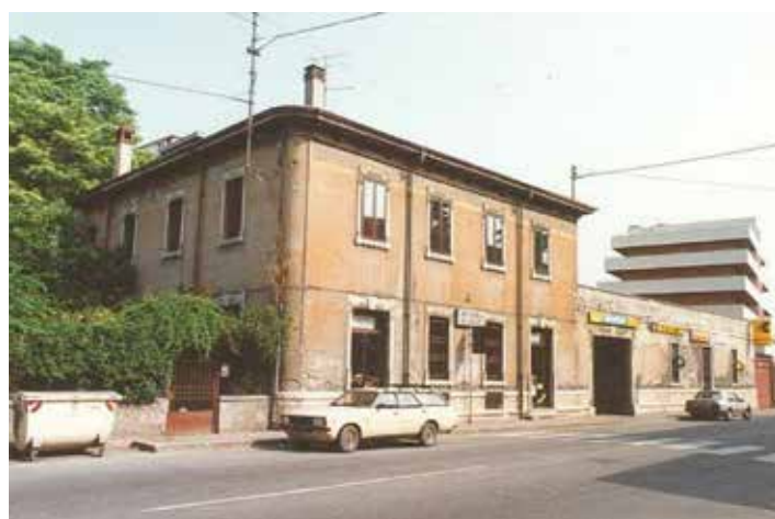
visione generale del fabbricato (1995)
