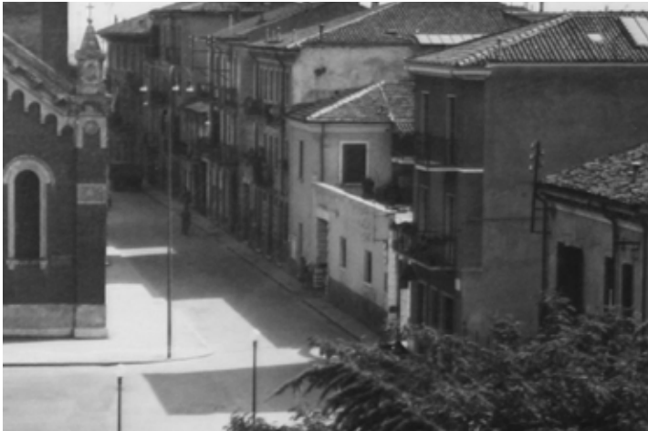
vista generale del fabbricato (1960 ca.)
