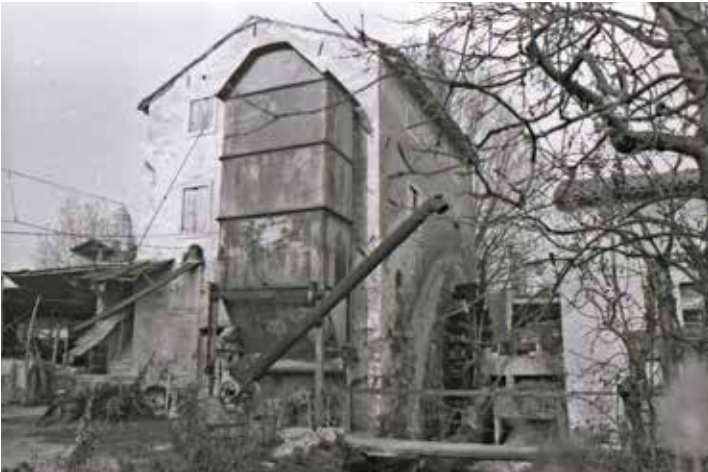
visione generale del fabbricato (1987)
